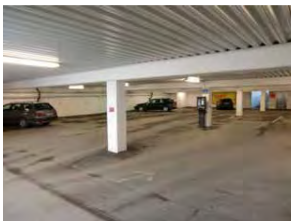
Figur 32. Parkeringsanläggningen i Edsbergs Centrum.
